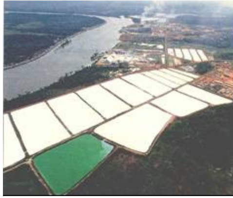
Figura II.2 - Lagos de resíduo de caulim situados no Município de Almeirim, PA.
