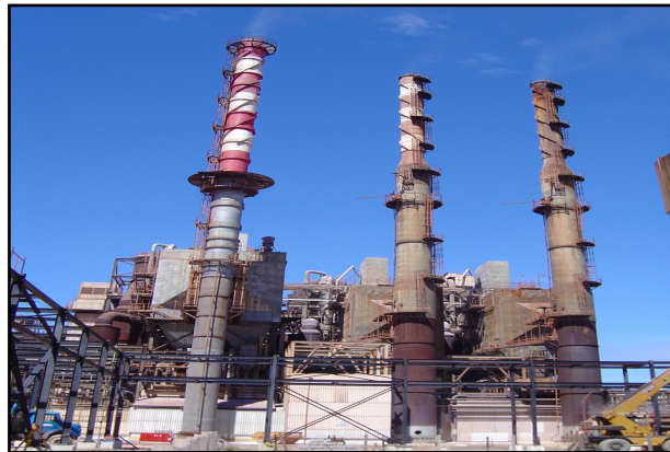
Figura III.7 - Calcinadores de alumina alfa. Fonte: ALUNORTE (2008).
