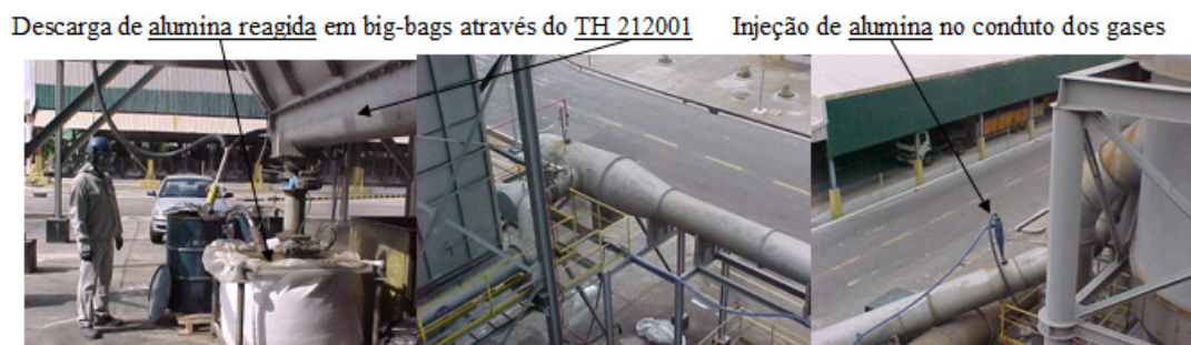
Figura 5.4 - Projeto provisório para lavagem a seco dos gases do forno de cozimento E da Albras.
