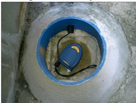
Fotografia 18: N1 na laje do RAP.
