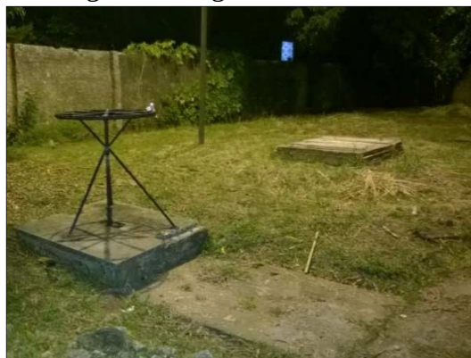
Fotografia 2: registro da subadutora.
