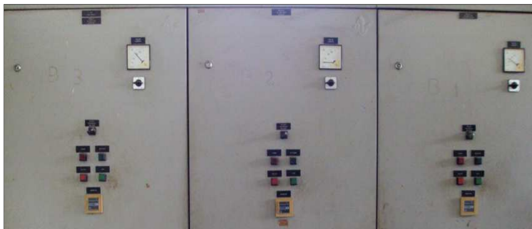
Fotografia 11: painel frontal do CCM do comando dos CMB 1, 2 e 3, indicados por B1, B2 e B3.
