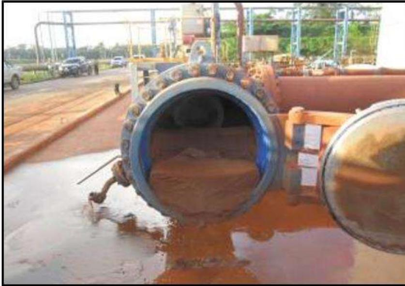
Figura 4.10 – Material retido em frente ao PIG. Fonte: COSTA (2016).
