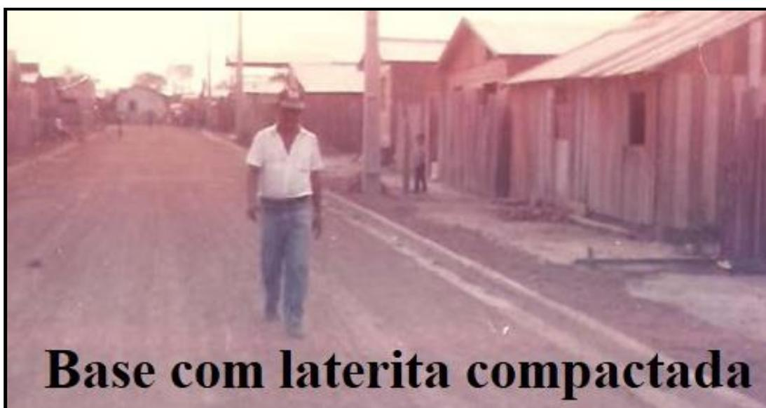
Figura 4.31 - Base com laterita à espera da imprimação e revestimento.
