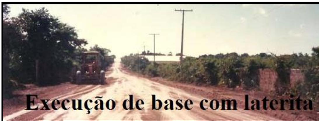
Figura 4.30 – Execução de base com laterita (piçarra).
